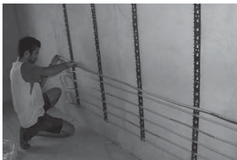
Rysunek 34 railjet układanie rury (instalacja wykonana przez partnera Purmo we Wrocławiu)
