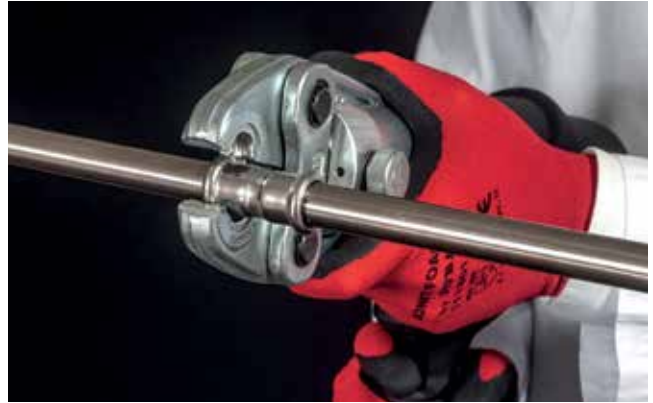
Assemblaggio attraverso pressatura / Making the press connection
