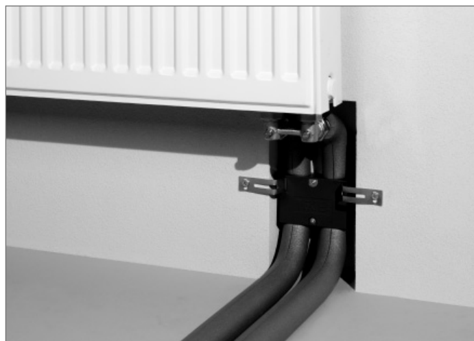
Przyłącze grzejnika wykonane za pomocą garnituru montażowego – po przyłączeniu do zespołu przyłączeniowego grzejnika
